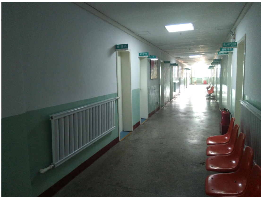
(供热管道改造)
